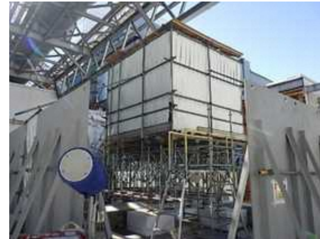
<遮蔽マット敷設状況>
