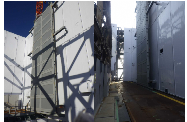
<上部架構用遮蔽パネル設置状況>
