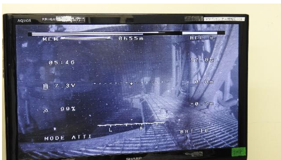
(写真3-1) 小型ドローンが撮影したPCV内部の状況 (ペDESTAL外部)
