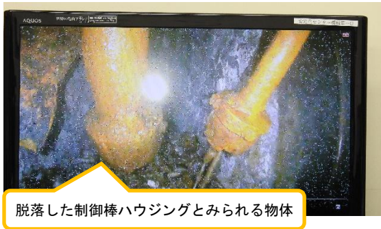
(写真3-3) 小型ドローンが撮影したPCV内部 の状況 (ペデスタル内部の状況)
