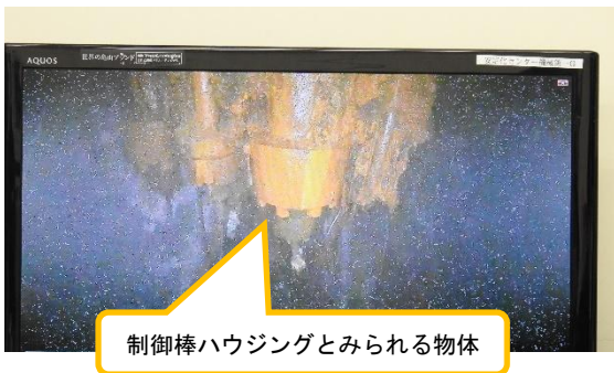
(写真3-2) 小型ドローンが撮影したPCV内部の状況 (ペDESTAL内部の状況)
