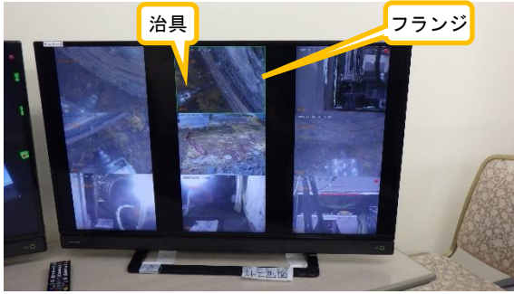
(写真2) 治具によるフランジ面の錆の除去作業の状況
