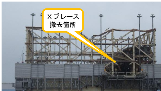
西面Xブレース撤去後の状況 (9月27日撮影)
