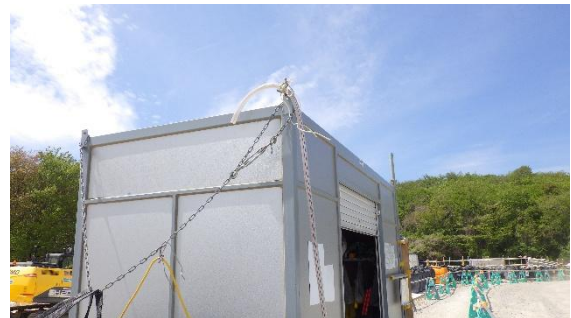
(写真3②) ダストモニタの吸引口
