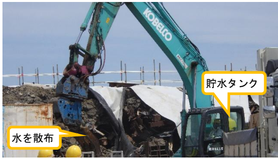
(写真2①) 重機の作業状況
