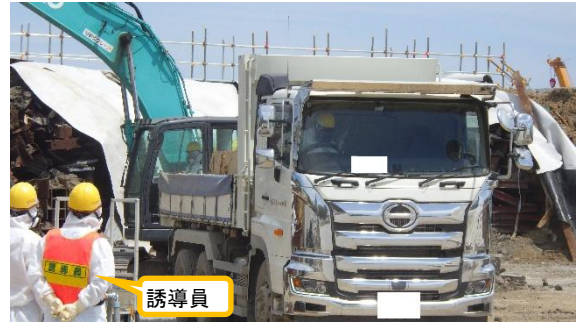
(写真2②) 瓦礫類のダンプ車への積み込み
