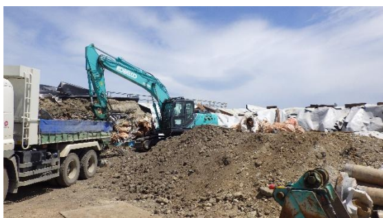
(写真1①) 第1工区
