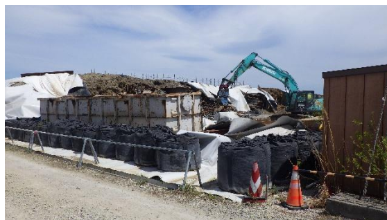
(写真1②) 第2工区
