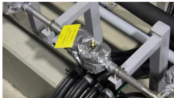
(写真2) 配管の養生
