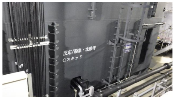
(写真3-2) 沈殿槽
