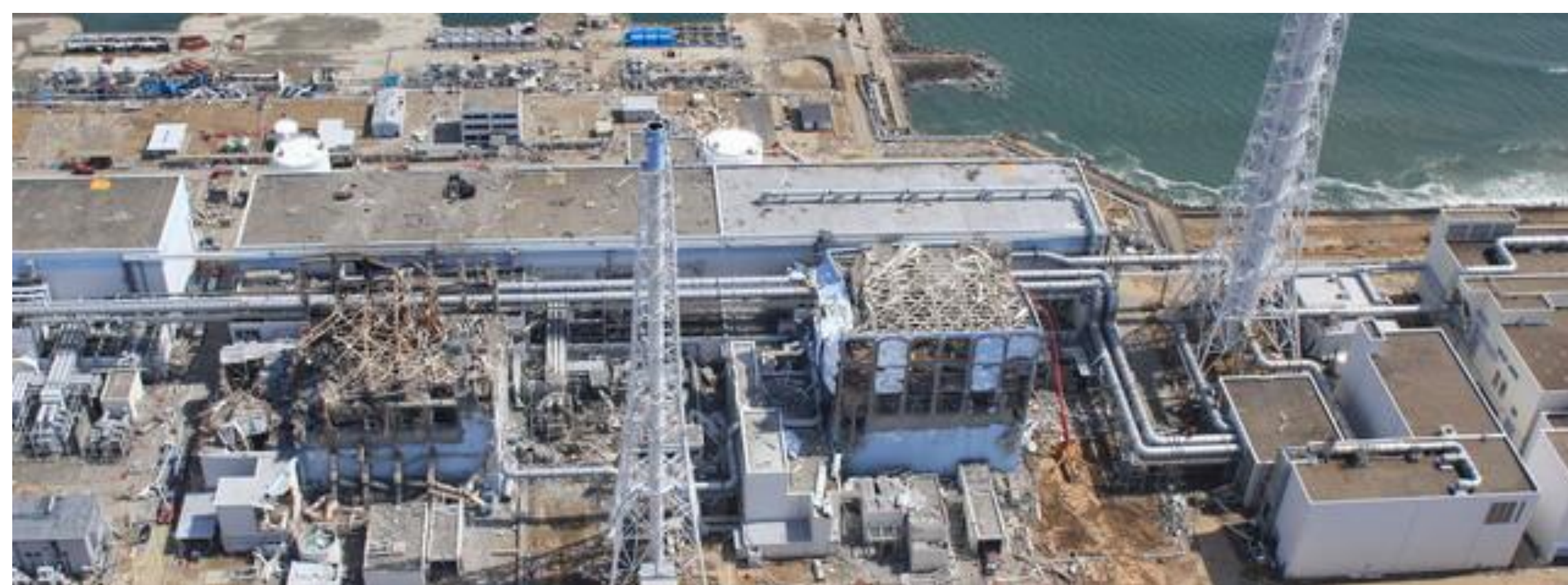
平成23年3月、東京電力（株）福島第一原子力発電所事故が発生
