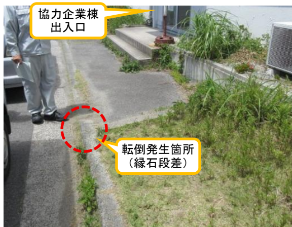
(写真3) 令和8年3月11日に不適合 (協力企業作業員転倒) の発生した段差箇所
