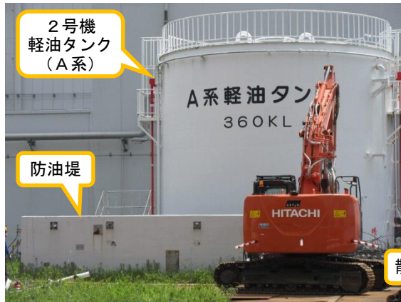
(写真1) 重機による2号機軽油タンク (A系) 防油堤の鉄筋コンクリートの解体作業の実施状況
