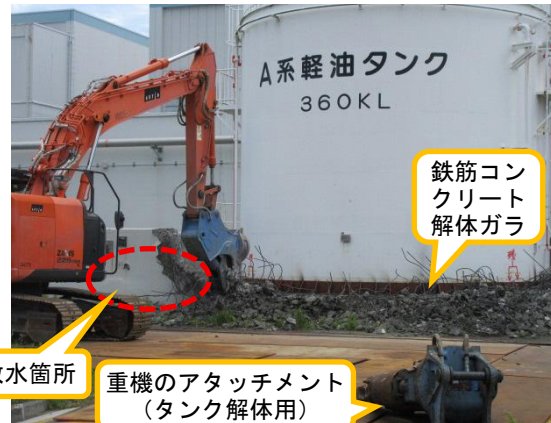
(写真2) 2号機軽油タンク (A系) 防油堤の鉄筋コンクリートの解体の実施状況 (写真左側から散水実施)
