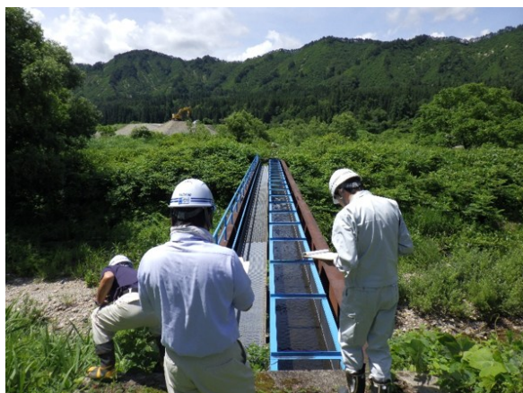
大金沢水路橋(只見町)点検風景
