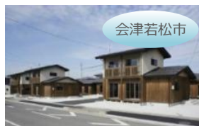
復興公営住宅：戸建
