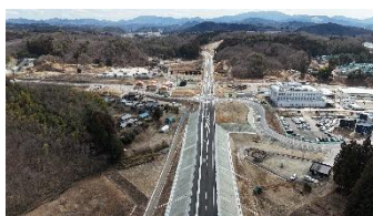
国道288号(船引バイパス) 2026年3月28日 開通
