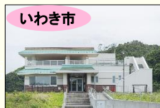
いわき市 いわき震災伝承みらい館
