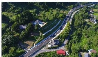
国道349号(大綱木工区) 2023年3月21日 完成
