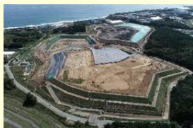
中間貯蔵施設（大熊⑤工区）の様子
