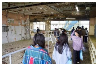
震災遺構浪江町立請戸小学校
