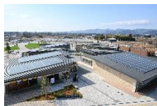
大熊町：商業施設
