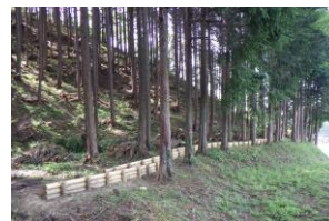
間伐・丸太筋工
