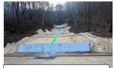
治山ダム整備（川向地区）
