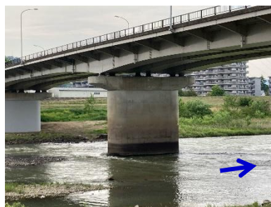
施工前 国道115号 文知摺橋 (福島市) ※橋脚巻立 施工後
