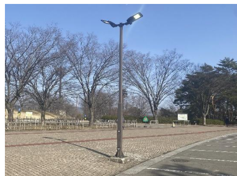
公園内照明のLED化
