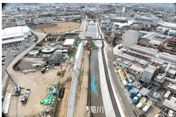
濁川（福島市鳥谷野） 堤防整備状況
