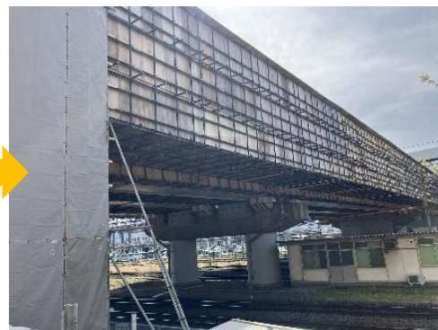
仮設足場完了
