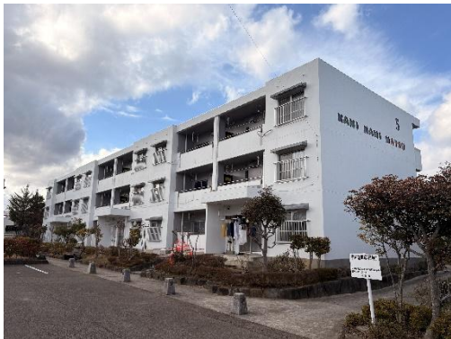
外壁改修の状況 上並松団地（R8.3竣工）
