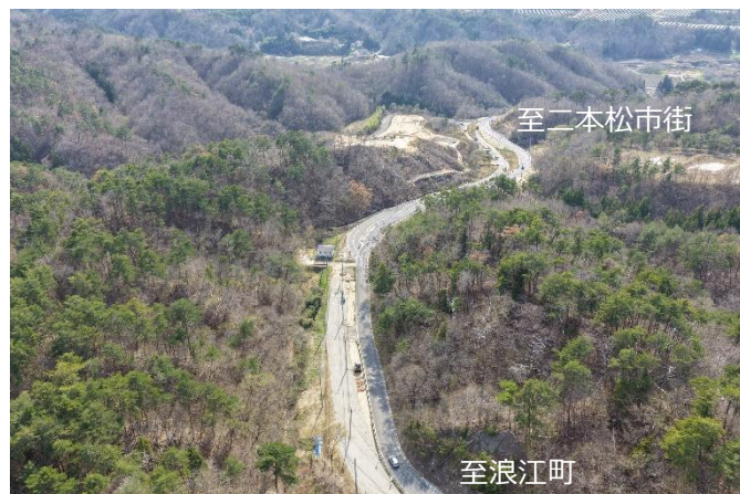
国道459号 西新殿工区 (二本松市西新殿)
