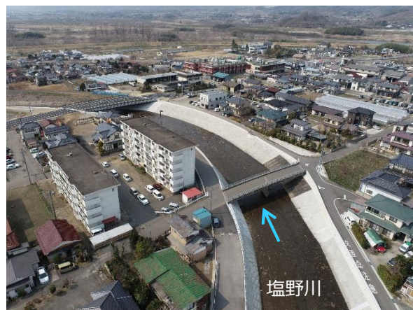
塩野川（伊達市梁川町） 堤防整備状況
