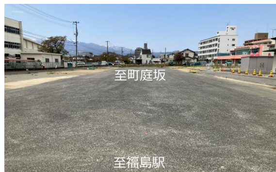
腰浜町町庭坂線 野田町工区 (福島市野田町)
