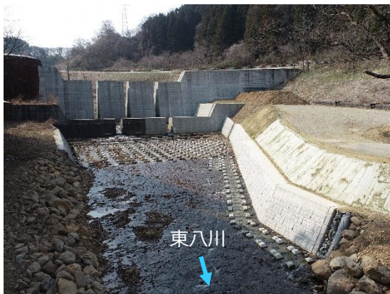
東八川（福島市松川町）下流護岸工完了
