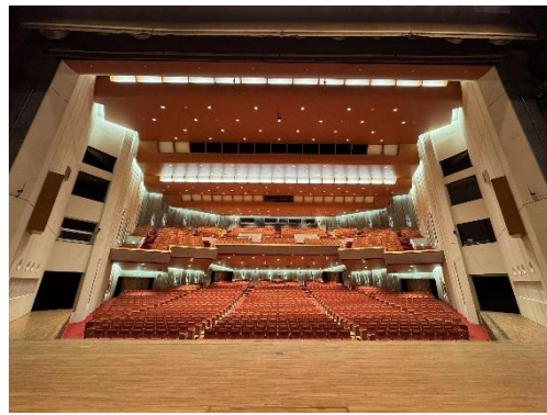
文化センター大ホール天井復旧改修工事 （R8.3竣工）
