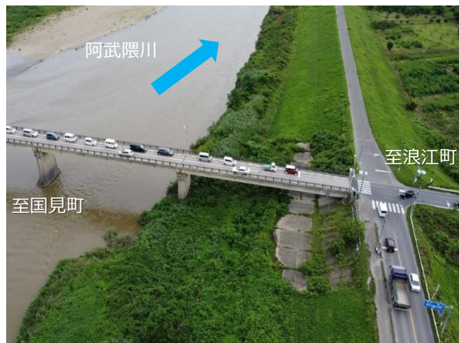
浪江国見線 伊達崎橋工区 (桑折町伊達崎)
