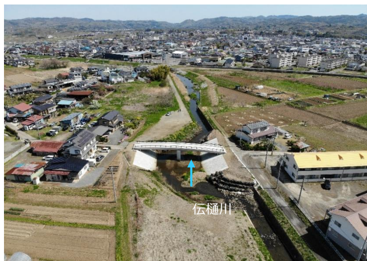
伝樋川（伊達市梁川町）東土橋 1 号橋上部工完了
