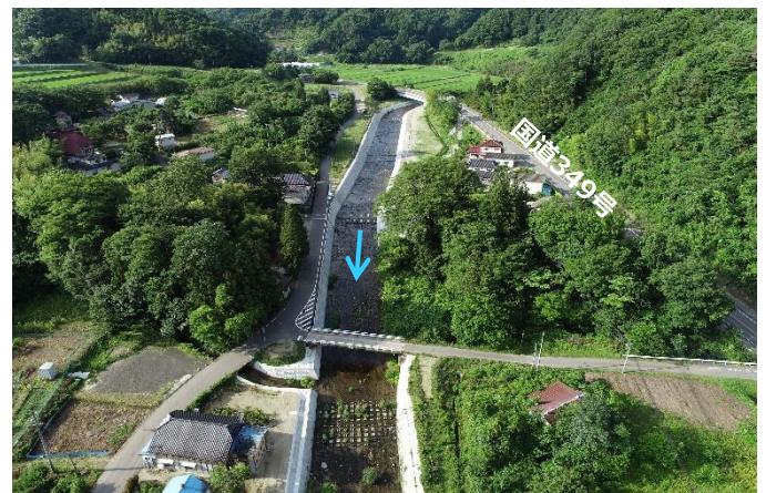
広瀬川（川俣町小島） 護岸整備状況
