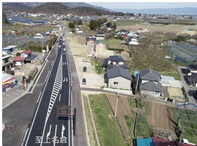
上名倉飯坂伊達線 福島大笹生2工区 (福島市大笹生)
