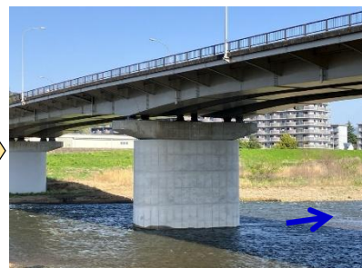
施工前 国道115号 文知摺橋 (福島市) ※橋脚巻立 施工後
