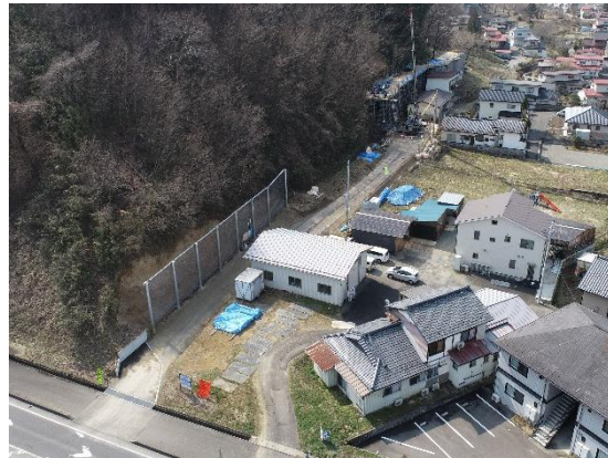
柏崎（川俣町）崩壊土砂防護柵工
