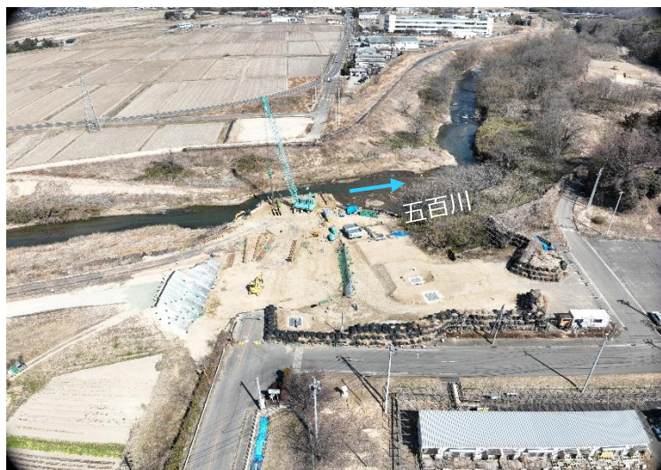
五百川（本宮市・郡山市）五百川橋旧橋撤去完了
