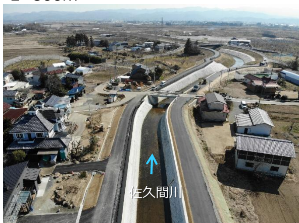
佐久間川（伊達郡桑折町） 堤防整備状況
