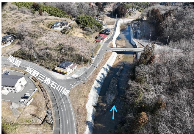
移川（二本松市上長折） 護岸整備状況
