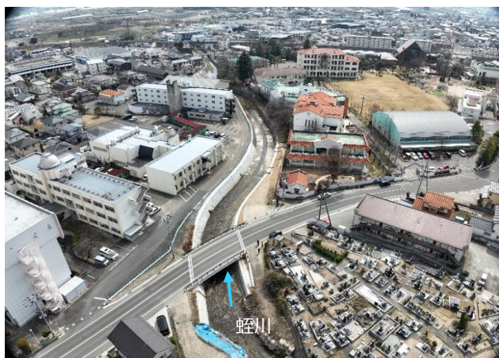
蛭川（福島市瀬上町）護岸整備状況
