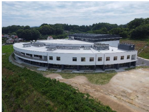
あだち支援学校（小中学部）新築工事 （R7.7竣工）
