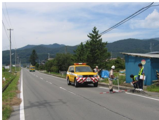
道路の異常を点検している様子
