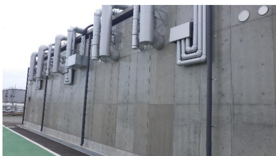
(写真 3－1) 化学分析棟増設部分①
