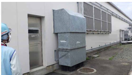
(写真 3－2) 化学分析棟増設部分②
