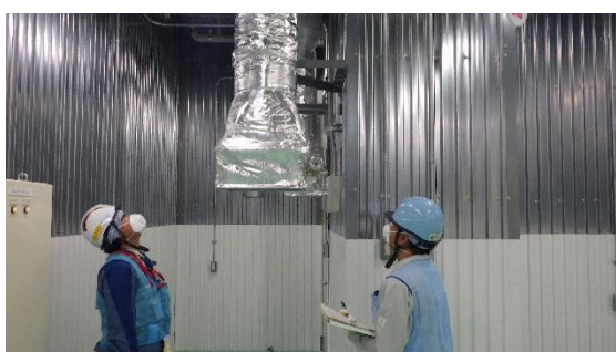
(写真 4－2) 化学分析棟増設部分建屋内の状況②
