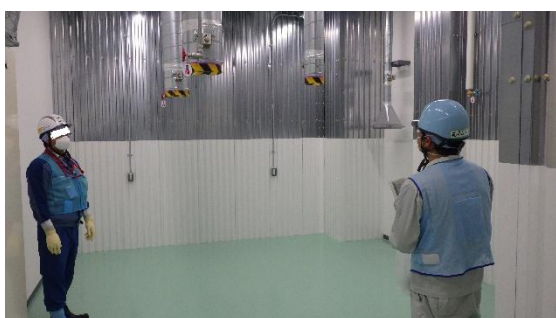
(写真 4－1) 化学分析棟増設部分建屋内の状況①
