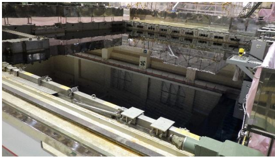
(写真 7) 6号機使用済燃料プールの状況
