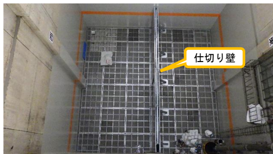
(写真2) ピットに設置された仕切り壁の状況
