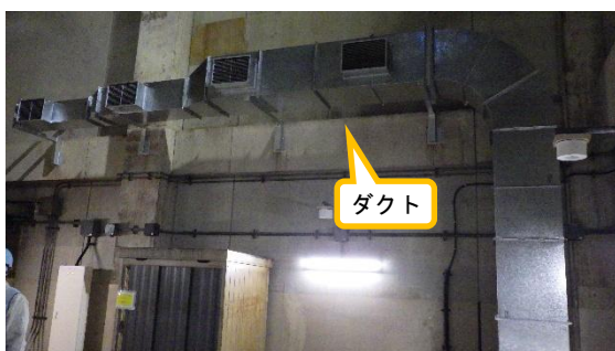
(写真 5) 換気のためのダクトの設置状況
