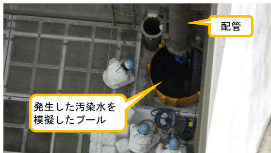
(写真1) ポンプの試運転の状況
