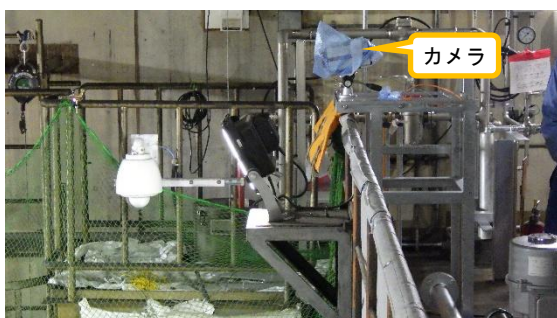
(写真 4) 温度監視のためのサーモカメラの設置状況
