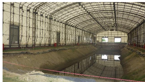
(写真1－2) 第4槽を覆うハウスの内部の状況
