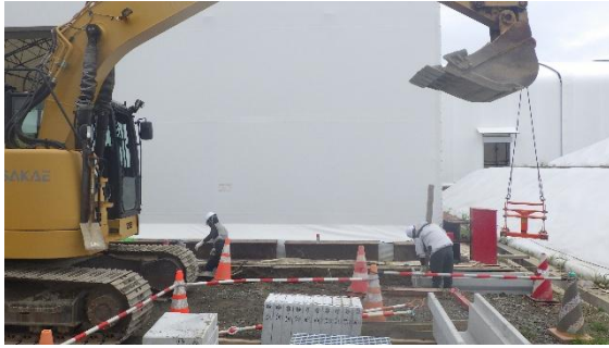
(写真 2 - 2) U字溝設置作業の状況 ②
