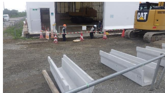
(写真2－1) U字溝設置作業の状況 ①
