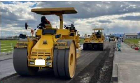
ロードローラ・タイヤローラによる締め固め
