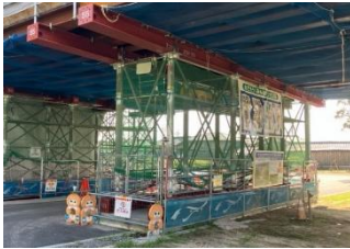
支柱支保設置状況
