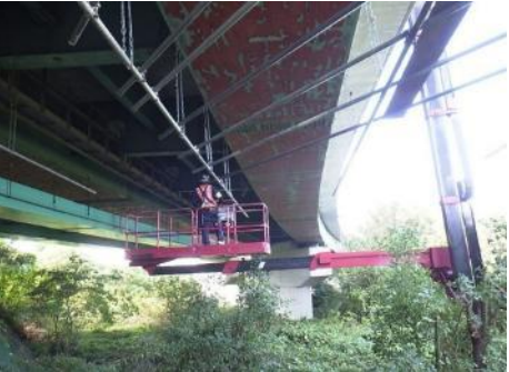
パイプ吊足場設置状況
