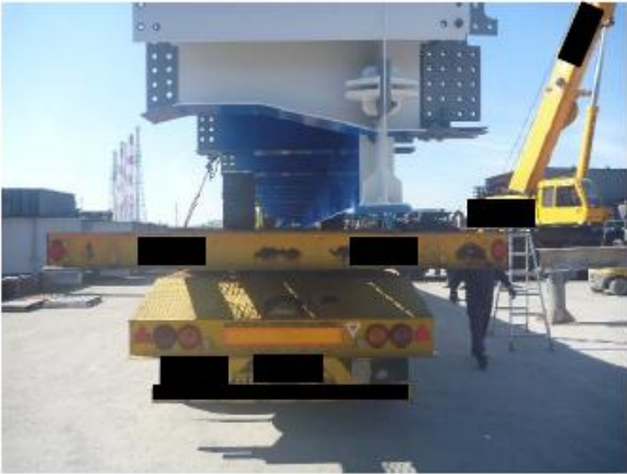
鋼床板鈹桁輸送状況
