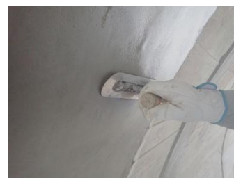
トンネル補修工 断面修復工 (左官工法)
