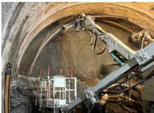
鋼製支保建込
