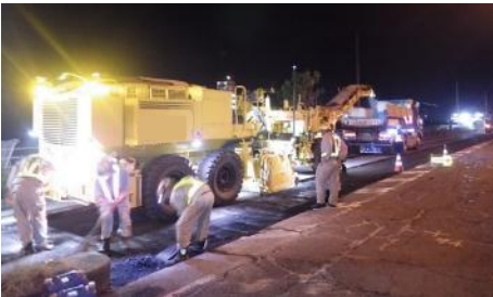
路面切削機 (ICT) による切削
