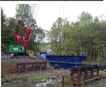
上部工 (仮設鉄桁) 架設状況
