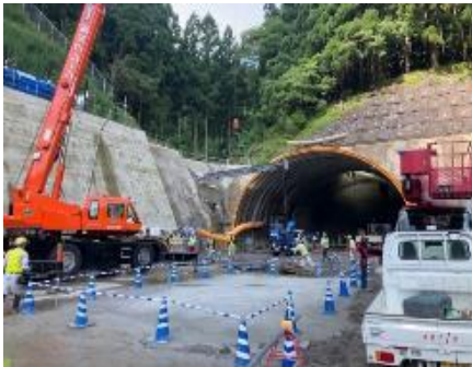
防音扉設置 (全景)
