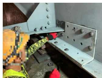
橋梁補修工 (高力ボルト当て板鋼桁補強工)
