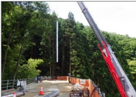
鋼管建込状況
