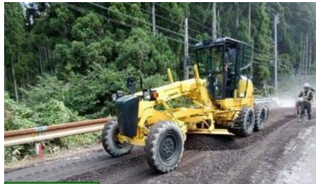
モータグレーダによる不陸整正
