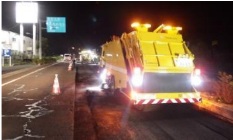
路面清掃車による清掃
