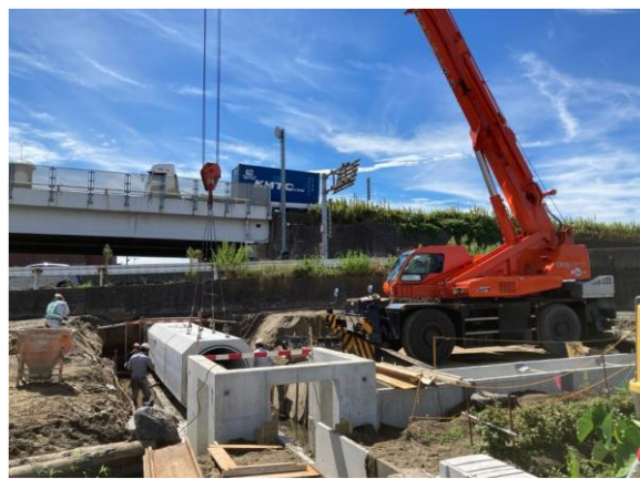
仮囲い設置状況
