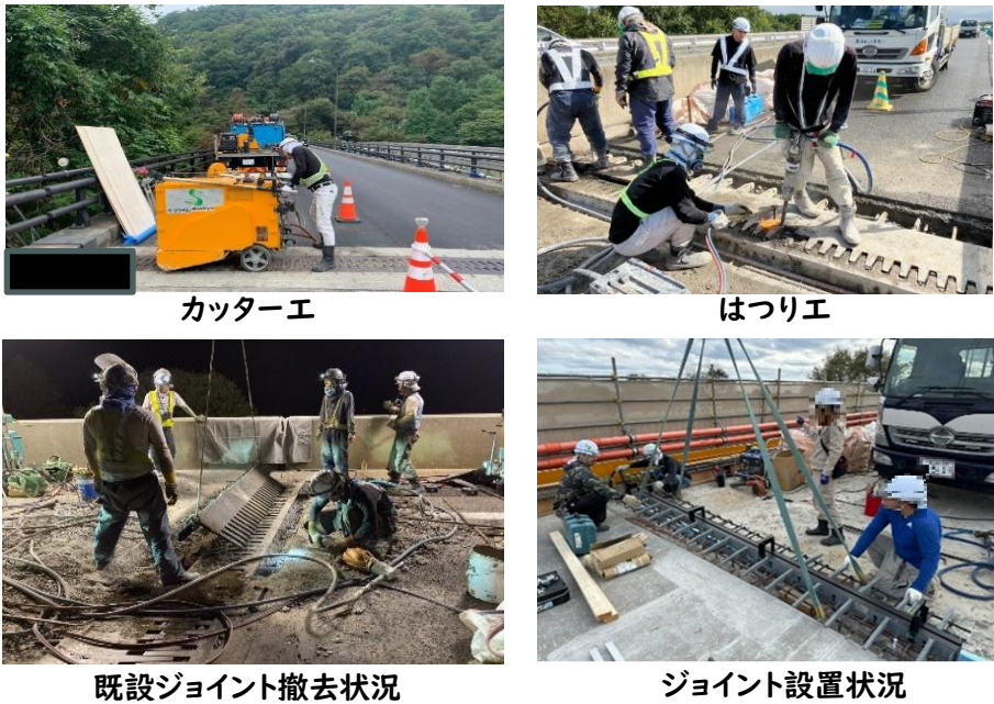
図4-1 施エフロー（鋼フィンガージョイント等から既製品ジョイントへの取替）
