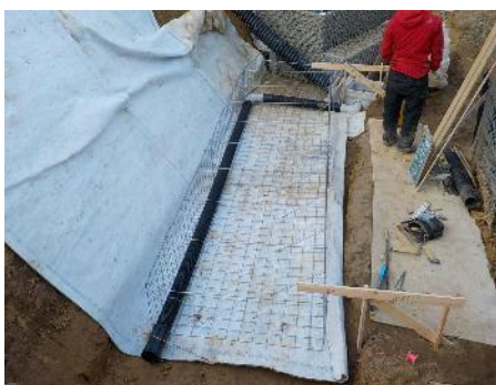
吸出し防止材設置
