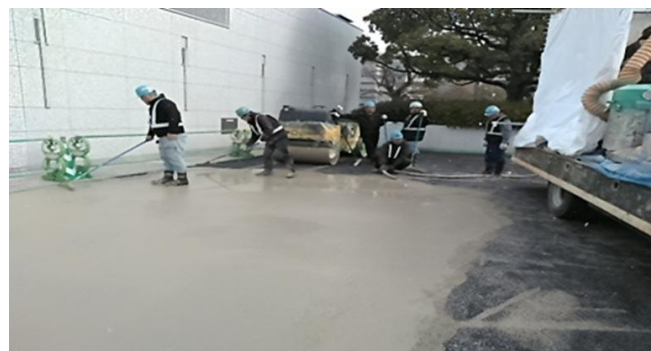
セメントミルク敷均し状況
