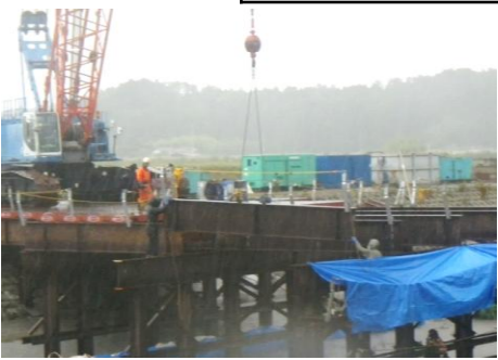
上部工 (H形鋼主桁) 架設状況
