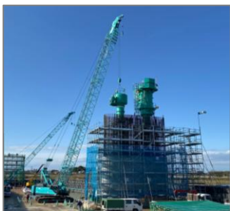
艀装設備組立
