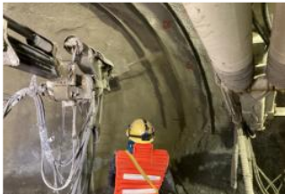
コンクリート吹付
