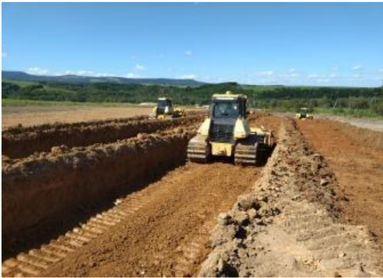
ブルドーザ施工状況②
