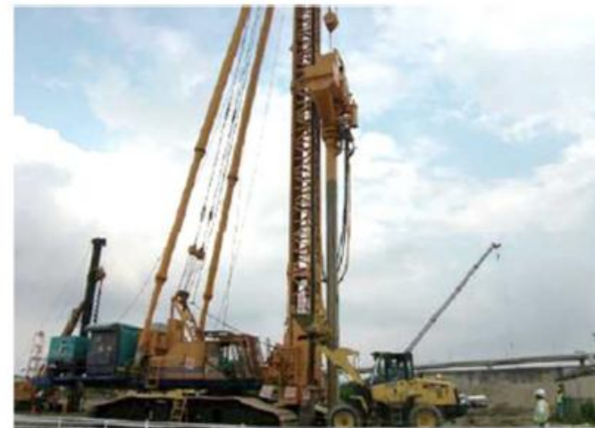
軟弱地盤処理工
