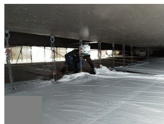
橋梁補修工 (塗装塗替足場工)
