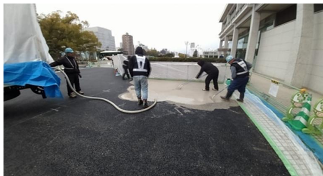
セメントミルク散布状況
