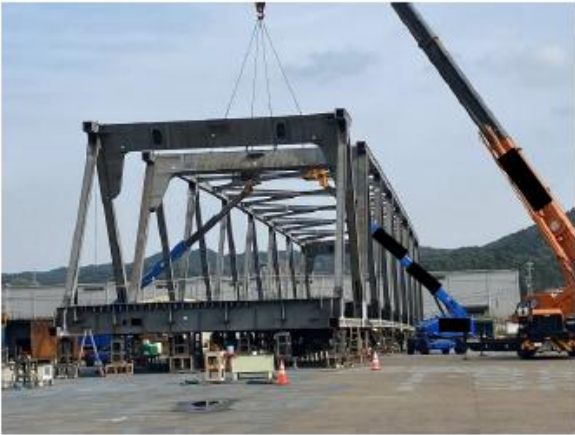
トラス仮組立状況
