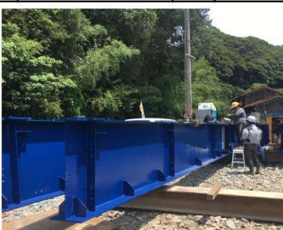
上部工 (仮設鉄桁) 地組状況
