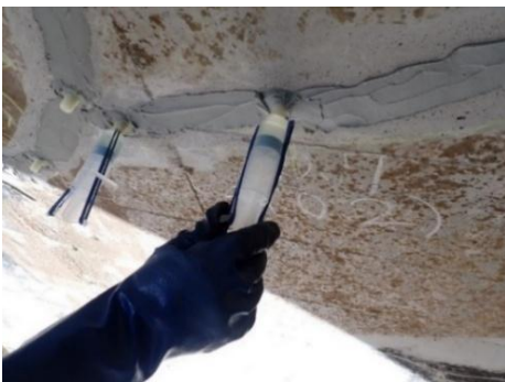
注入器具取付
