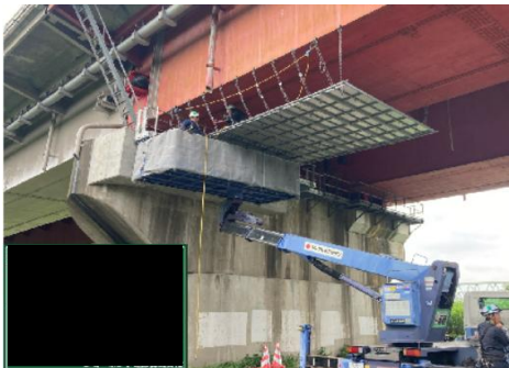
システム（パネル式）吊足場設置状況
