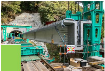
架設桁架設状況
