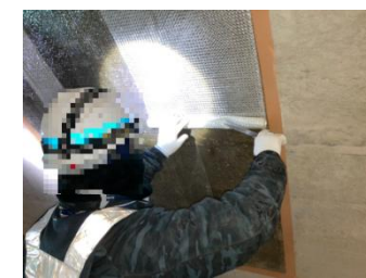
トンネル補修工 剥落防止対策工 (可視繊維シート接着工)
