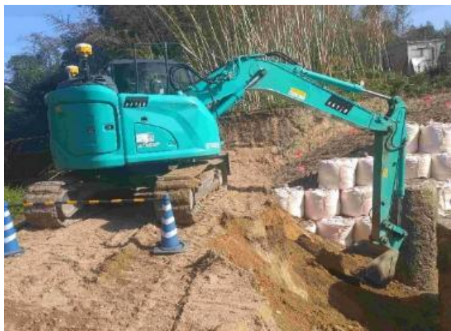
3D-MCバックホウによる床掘作業
