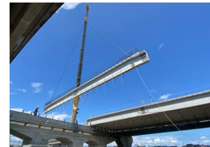
PC橋架設エ
