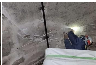
線導水(溝切り工)作業状況
