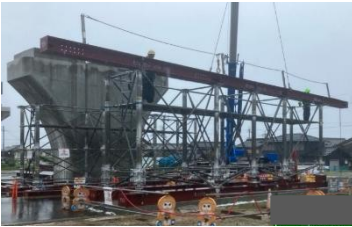
受桁設置状況
