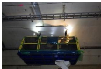
面導水作業状況
