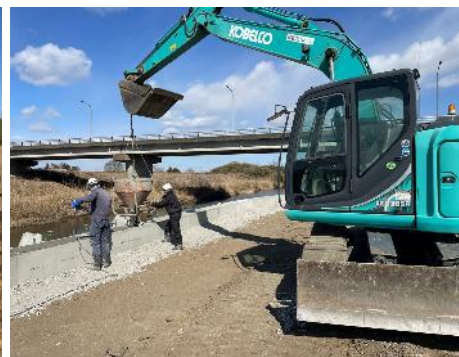
中詰コンクリートエ
