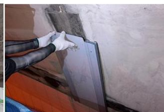
線導水(導水樋工)作業状況
