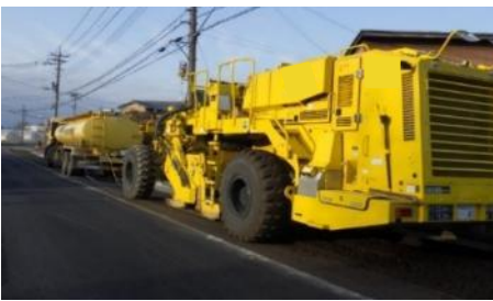
スタビライザによる破碎混合・乳剤散布
