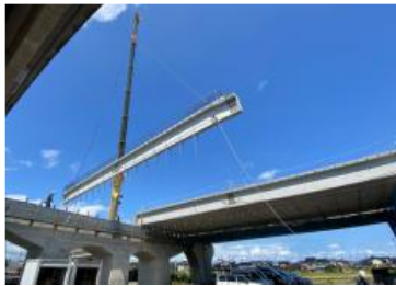
クレーン架設
