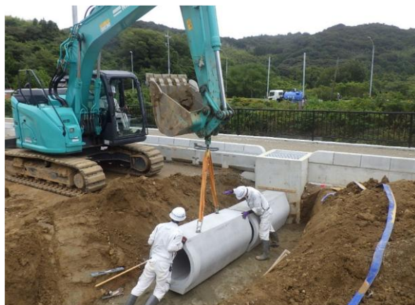
丸パイプ土中打込作業状況
