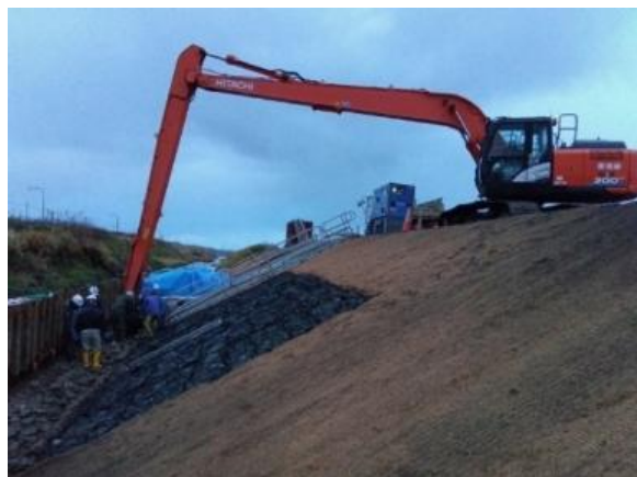
捨石投入 (バックホウ 超ロングアーム型)
