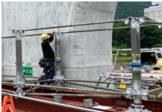
大型パイプ支柱設置状況
