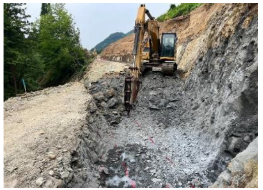
大型ブレーカ掘削
