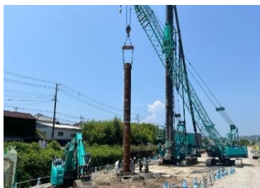
鋼管ソイルセメント杭エ
