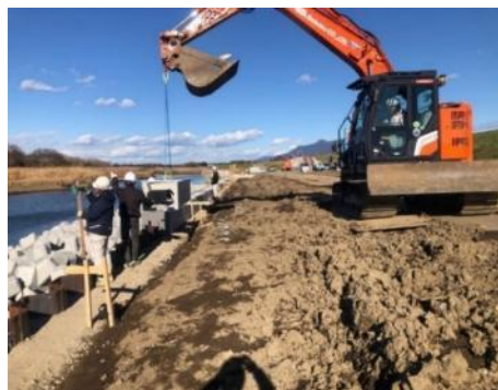
笠コンクリートブロック据付
