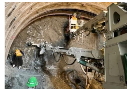
トンネルエ (NATM) [発破工法]
