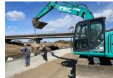
笠コンクリートブロック据付工
