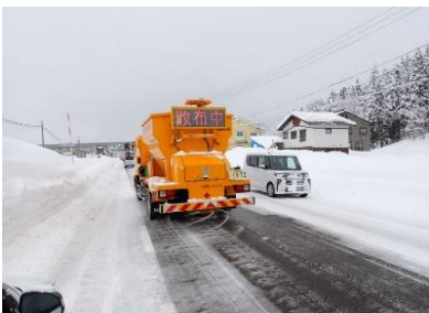
凍結防止剤散布状況
