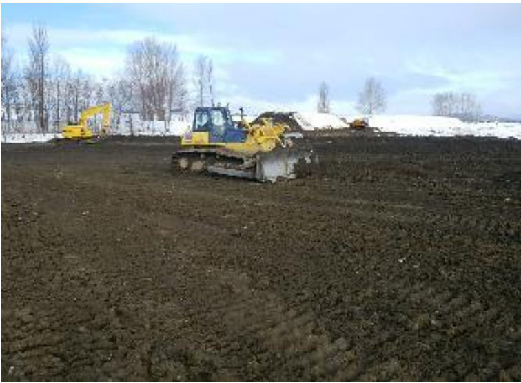
ブルドーザ施工状況①
