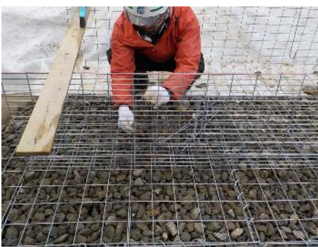
かが組立・据付け
