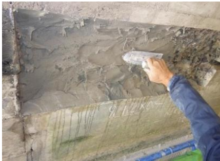
断面修復(左官)施工状況
