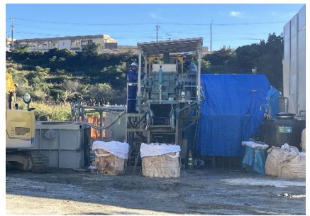
発生土積込状況
