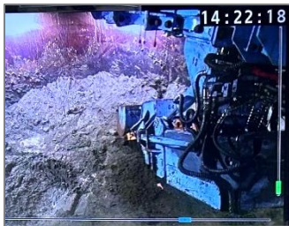
沈下掘削 (無人掘削)
