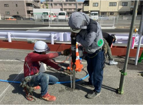
丸パイプ土中打込作業状況
