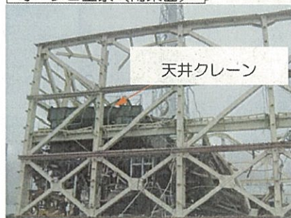
オペフロ全景(南東面)
