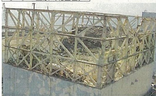
オペフロ全景(北西面)
