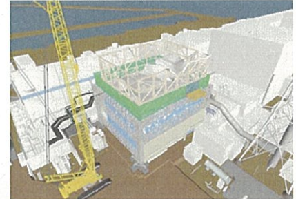
⑥建屋カバー解体完了
