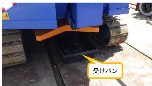
(写真 5) オイル漏れ対策
