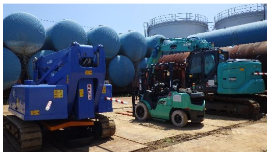
(写真 4 ①) 重機の保管状況①
