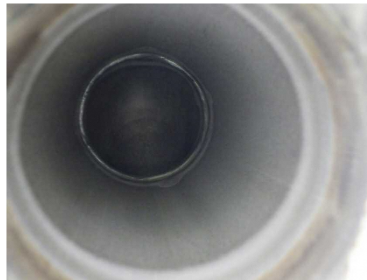
薬液洗浄後の配管内部写真。吸着塔入口付近の配管開放部より内部を撮影。
