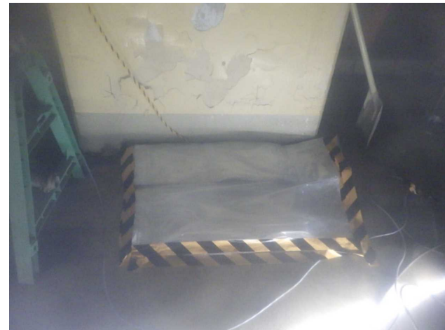
<鉛遮蔽設置状況>
