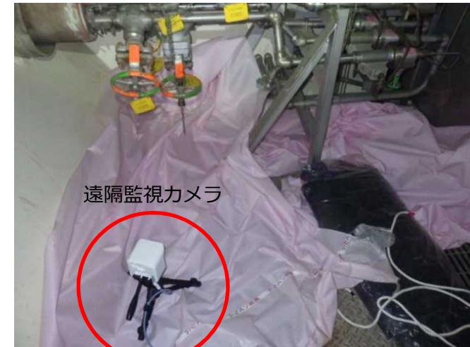
＜遠隔監視カメラ（X-28ペネトレーション前）＞
