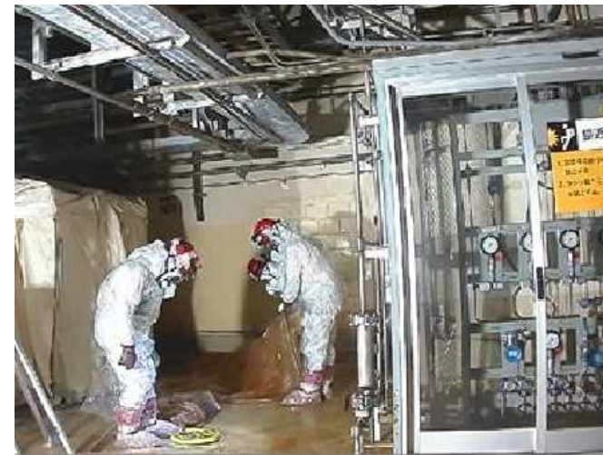
＜除染剤剥離作業＞
