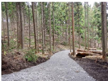
森林作業道の開設
