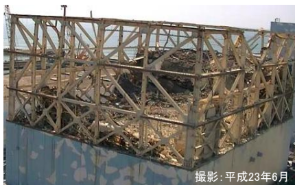
建屋カバー設置前の状況
