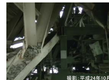
建屋カバー内の状況
