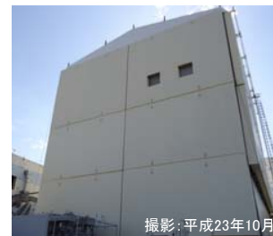
建屋カバーの設置状況
