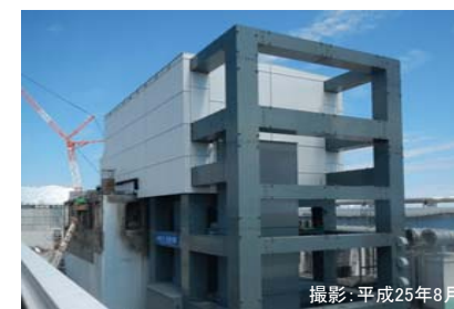
燃料取出カバー設置後
