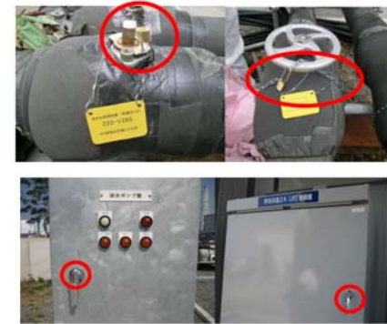
弁・電源盤の施錠管理状況
