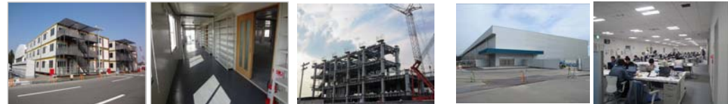
仮設休憩所と建設中の大型休憩所
