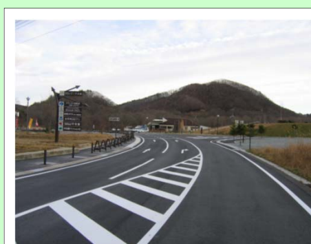
施工後(終点側)
