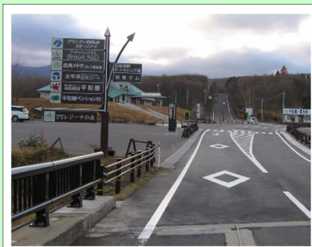
施工後(起点側)
