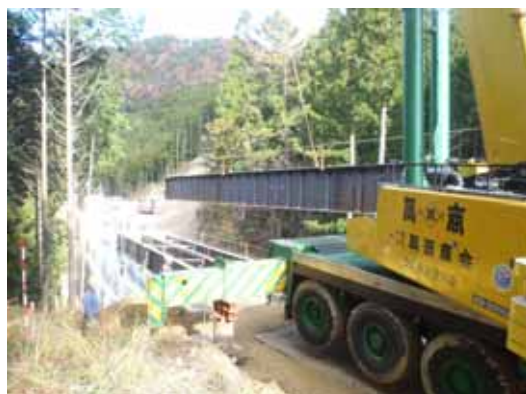
(桁の架設工事の様子)
