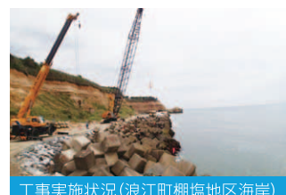
工事実施状況(浪江町棚塩地区海岸)
