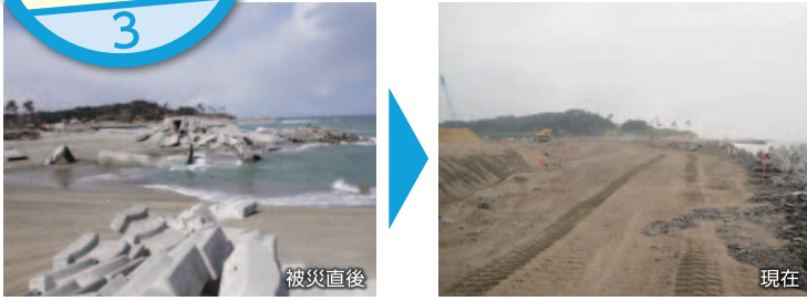
相馬郡新地町木崎地区海岸の工事状況
