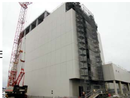
建設中の大型休憩所
