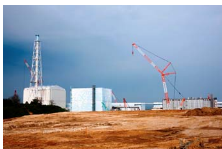
木々の伐採状況
