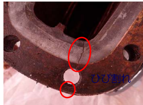
ガスケット取り外し後
