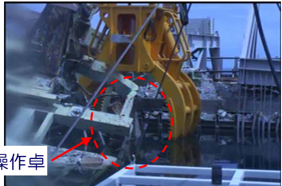
写真③ 爪5本で撤去しようとした状況 (西側 側方より撮影)
