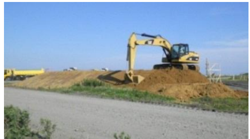
【原町地区における盛土工事の様子】
