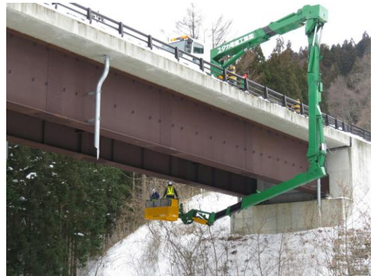
【橋梁点検車を用いた点検の様子】
