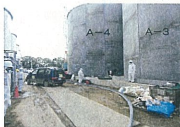
A-3、A-4タンク本体および基礎について 目視点検を行い異常なし。
