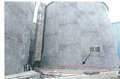
A-3、A-4の仮堰について目視点検を行い異常なし。
