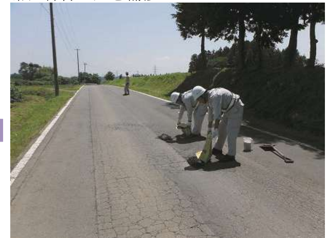
常温合材で穴を補修
