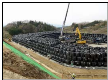
仮置場 搬入中
