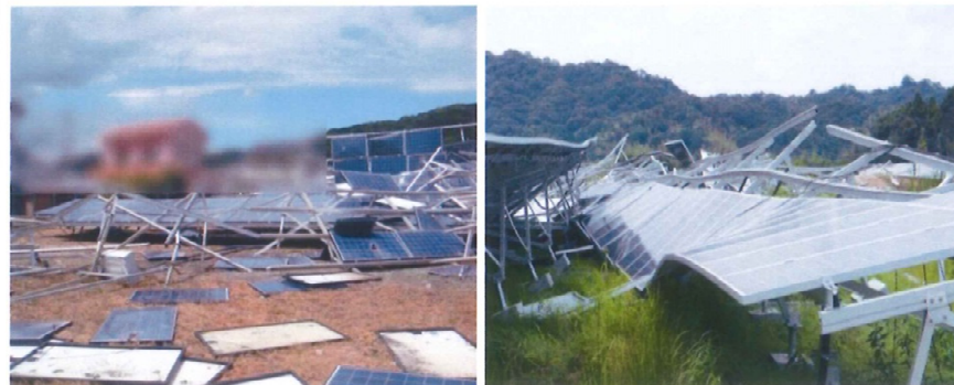
パネル飛散の例（昨年8月 台風15号によるもの）
