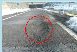
舗装補修 作業前
