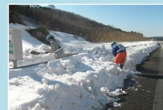
非常用電話周りの除雪状況
