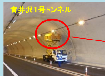
点検実施状況
