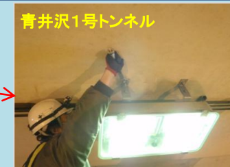
ナットの締め付け状況を確認
