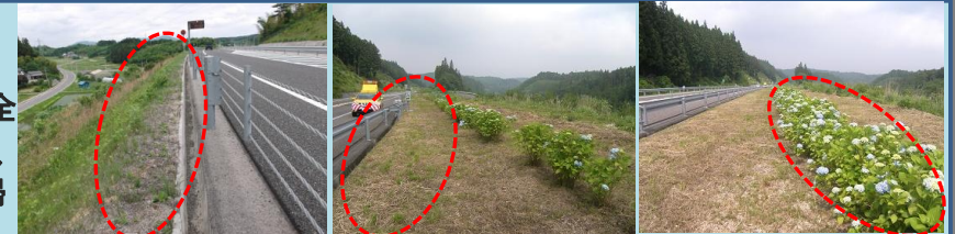
道路路肩部 草刈り状況
