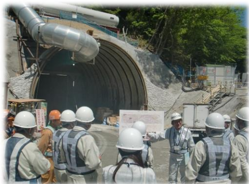
現地調査の様子（鳳坂トンネル）
