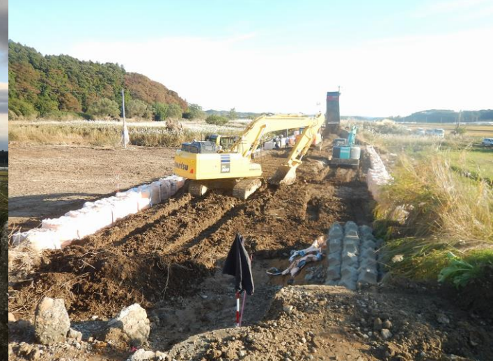
阿武隈川と鈴川の堤防決壊箇所への大型土のう設置（鏡石町河原地区）
