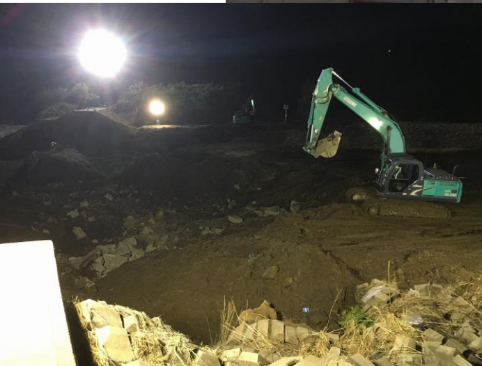
阿武隈川堤防決壊箇所への大型土のう設置（鏡石町諏訪町地区）
