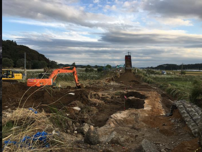
阿武隈川と鈴川の堤防決壊箇所への大型土のう設置（鏡石町河原地区）
