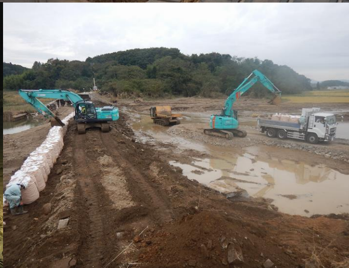
阿武隈川堤防決壊箇所への大型土のう設置（鏡石町諏訪町地区）
