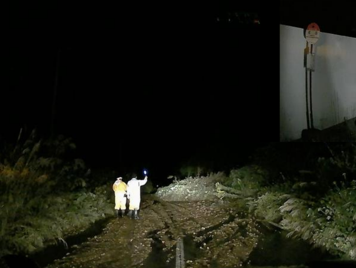
県道十日市矢吹線 土砂流出 (天栄村大字大里付近)
