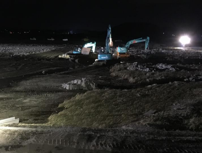
阿武隈川と鈴川の堤防決壊箇所への大型土のう設置（鏡石町河原地区）
