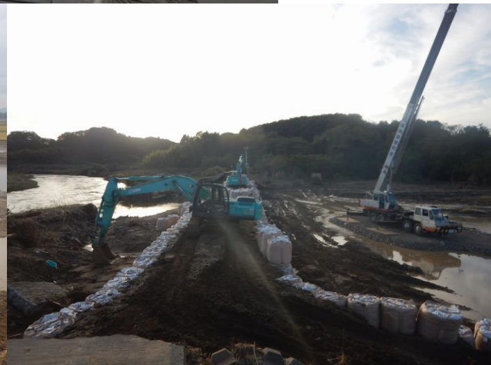
阿武隈川堤防決壊箇所への大型土のう設置（鏡石町諏訪町地区）
