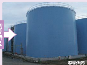
溶接型タンク
