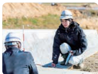
排水路の寸法測定
