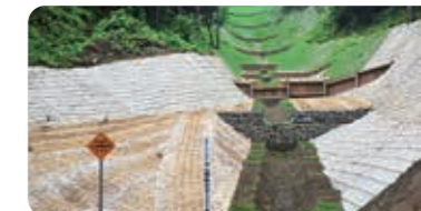
復旧工事が完成した現場
