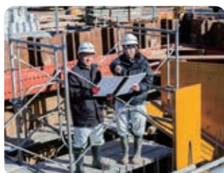
橋梁の施工状況確認
