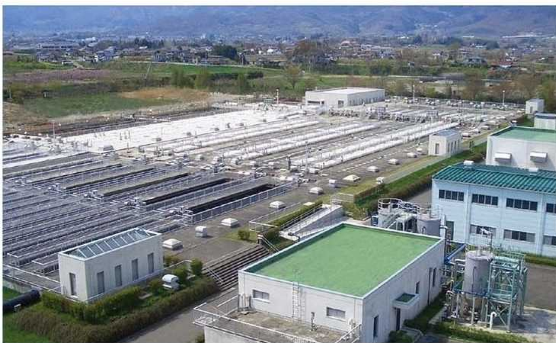
県北浄化センター水処理施設
