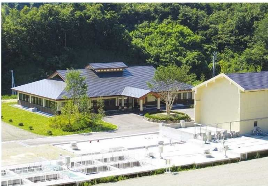
大滝根水環境センター
