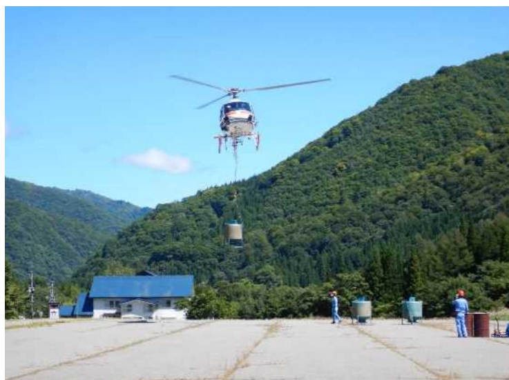
ヘリコプターによる資材運搬状況 (R4.9)
