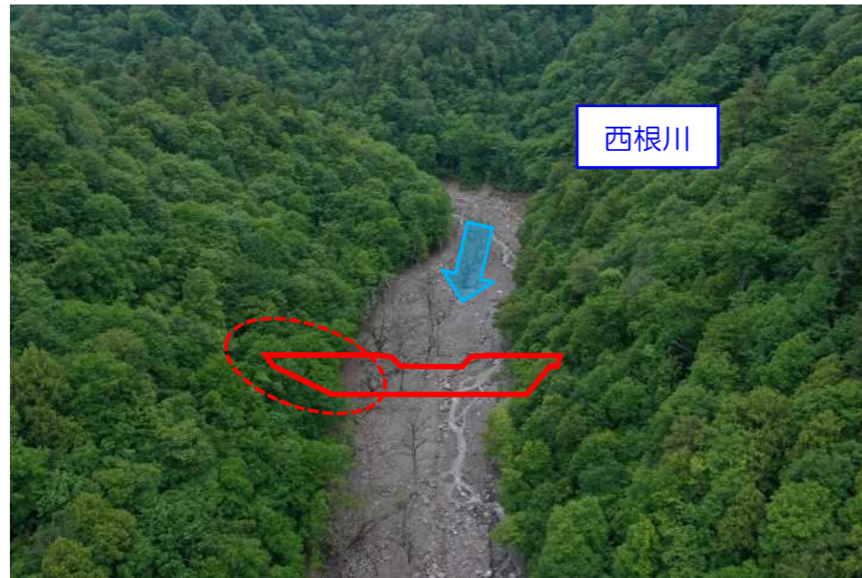
西根川上流地区復旧治山工事 事業内容：治山ダム新設
