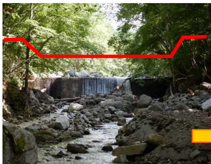
コンクリート谷止工の嵩上げ
