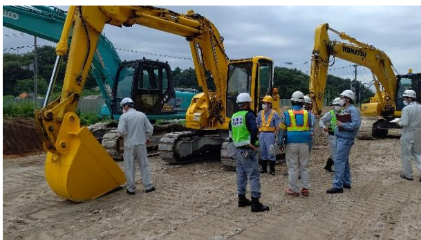
点検状況＜須賀川、石川方部＞
