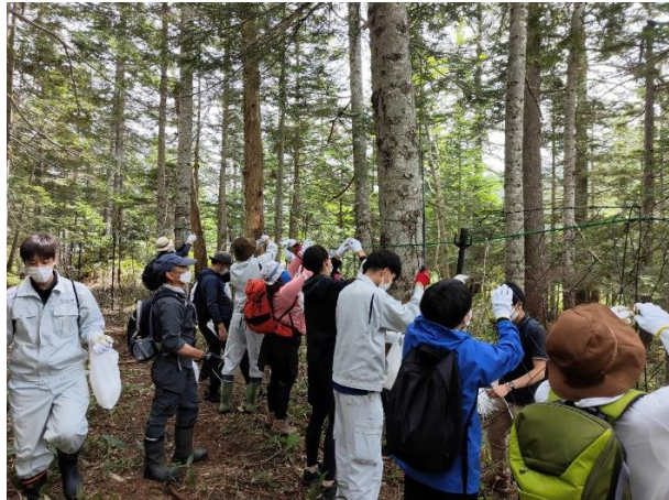
関係者、ボランティアによる柵の設置作業
