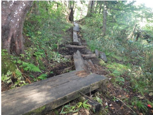
老朽化、破損した木道
