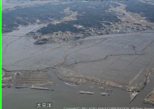
H23.3.12 震災翌日の湛水状況（南相馬市原町区）
