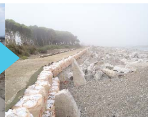
応急工事（仮締切（大型土嚢））
