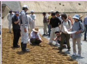
地元説明会（盛土状況）
