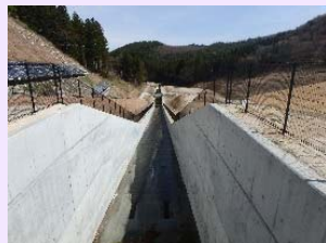
洪水吐の断面拡大
