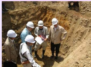
復旧委員会による土質確認
