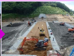
H28.6 本堤盛土状況
