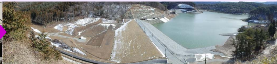
H29.3 湛水試験状況
