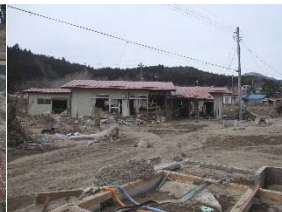
下流家屋の被害
