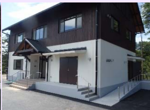
ダム管理棟の新設
