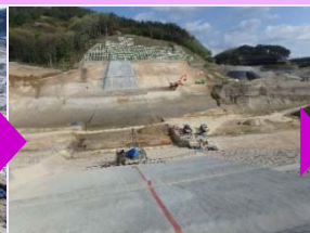
H27.5 本堤掘削完了
