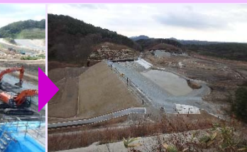
H28.12 本堤盛土完了
