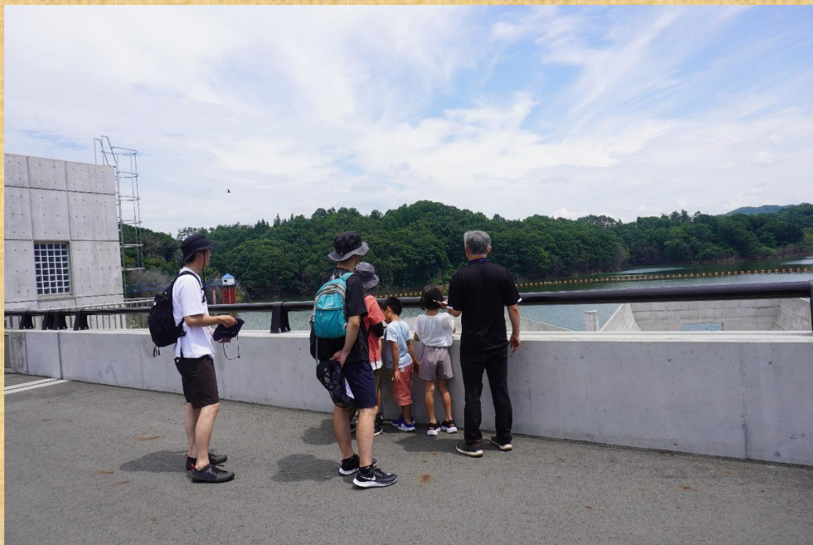
洪水吐部付近を現地見学
