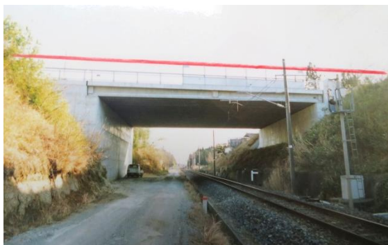
施工前（赤線は架設位置）
