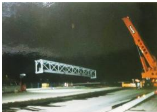
架設の様子（夜間）
