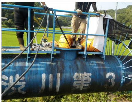
導水路修繕工事
