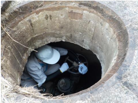
排泥弁の開閉作業
