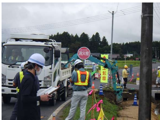
点検状況＜須賀川、石川方部＞
