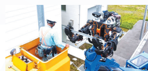
市街地エリアにおける信号機の取り付け作業のデモ
